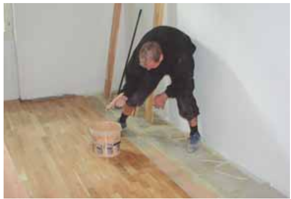
Pokládání lamelových parket na podlahu F146
