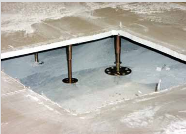
Podlaha Camillo před vylitím sádrového potěru FE 80
