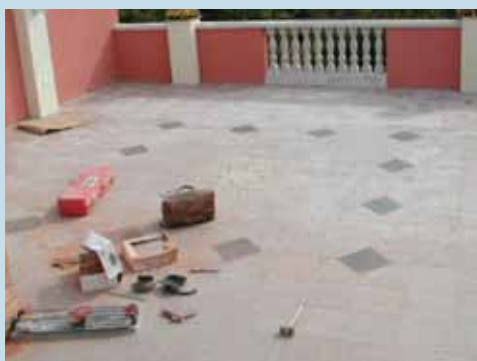
Použití Aquapanelu na terase
