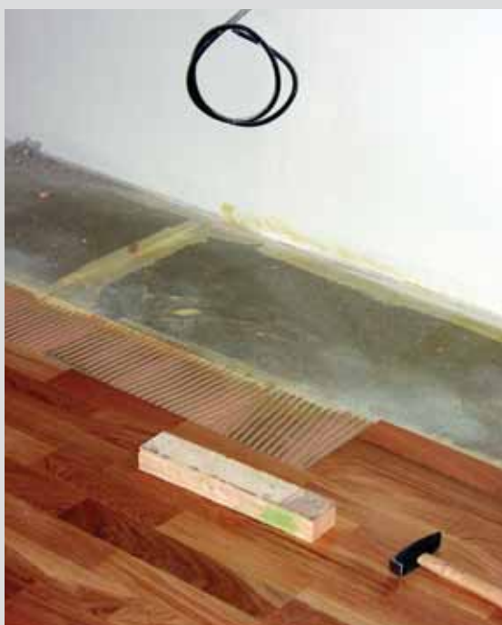
Montáž plovoucí podlahy na F146
