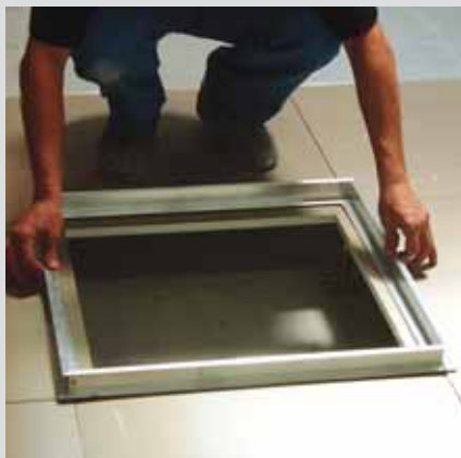
Vložení hliníkového revizního rámu do podlahy Camillo
