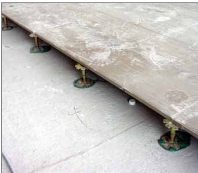
Podlaha Camillo před vylitím sádrového potěru FE 80
