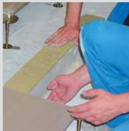
Montáž akustické přepážky
