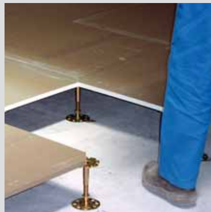
Montáž podlahy Camillo
