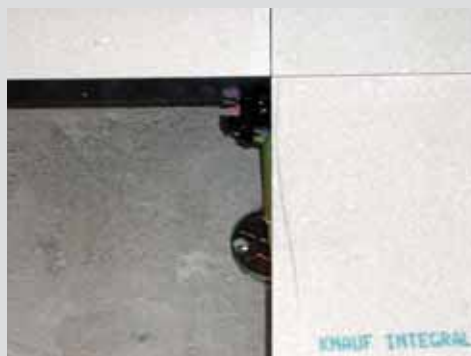
Detail dvojité podlahy KNAUF Integral
