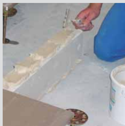
Příprava pro montáž akustické přepážky
