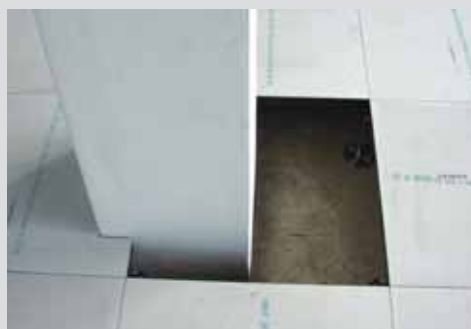
Dvojitá podlaha KNAUF Integral - desky u sloupu
