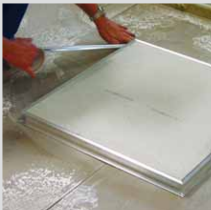
Zajištění rámu před litím KNAUF FE 80
